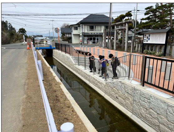
【村崎野幹線(整備後)】
