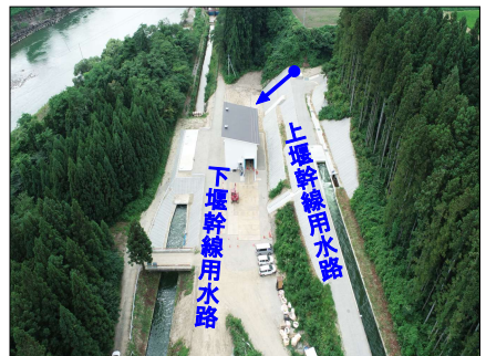
【和賀中央発電所】
