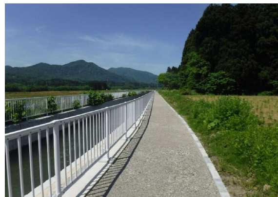
下堰幹線用水路（施工中）
