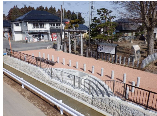
村崎野幹線用水路
