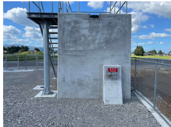
中笹間配水槽（施工中）
