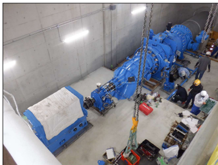
【発電機据付状況】
