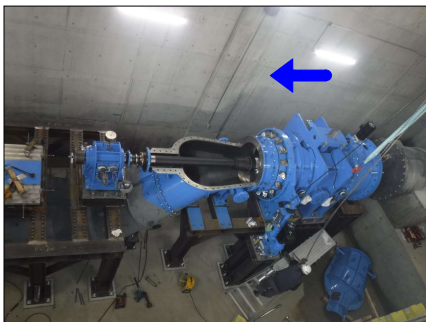
【水車据付状況】
